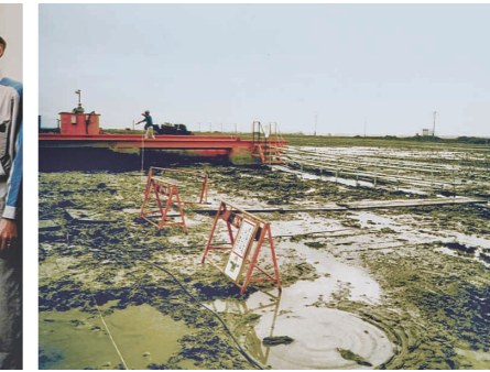
地盤改良工事着手時の知多緑浜工場建設予定地
