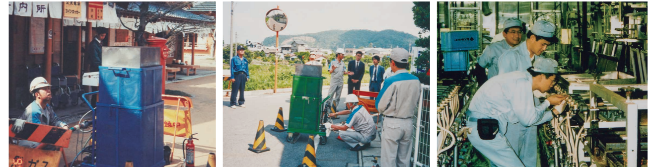
他ガス事業者への天然ガス転換支援(左:合同ガス、中:犬山ガス、右:中部ガス)
