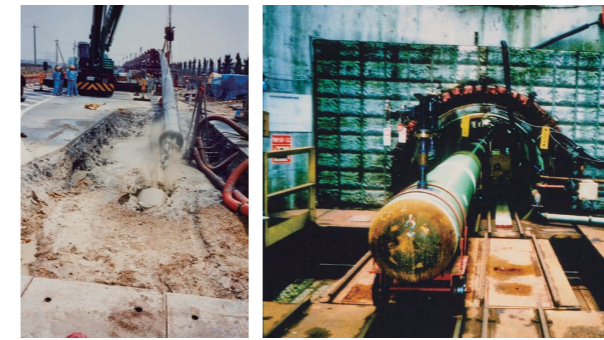
PLAD工法施工現場
