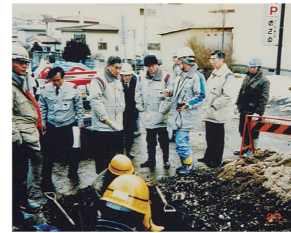
被災地での復旧活動(釧路沖地震)
