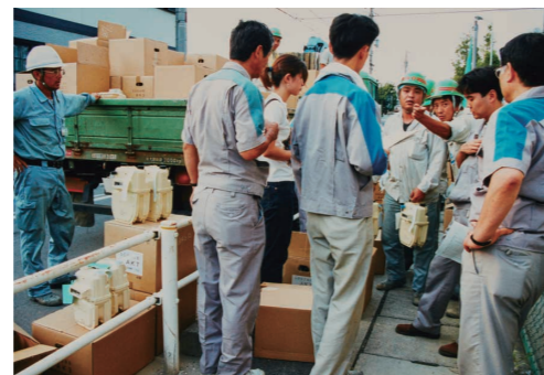
前進基地におけるメーター取替準備作業
