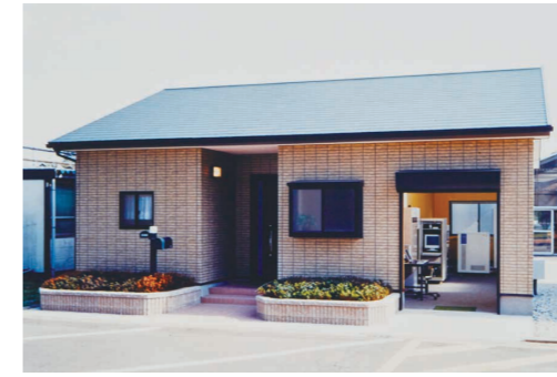
固体高分子形燃料電池実験住宅
