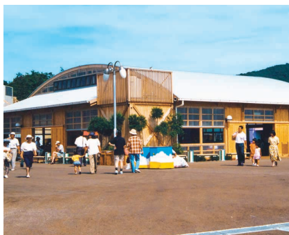
ガス冷房付き木造休憩所(まつり博・三重'94)
