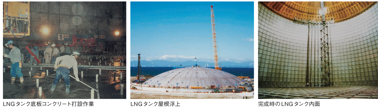
LNGタンク底板コンクリート打設作業
