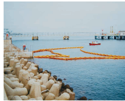
オイルフェンスの整備
